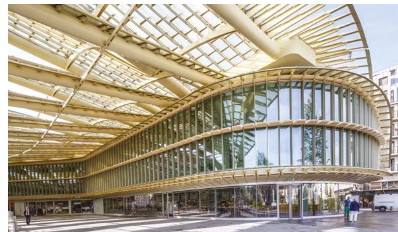
La Canopée des Halles de Paris, un chantier du groupe Fayat
