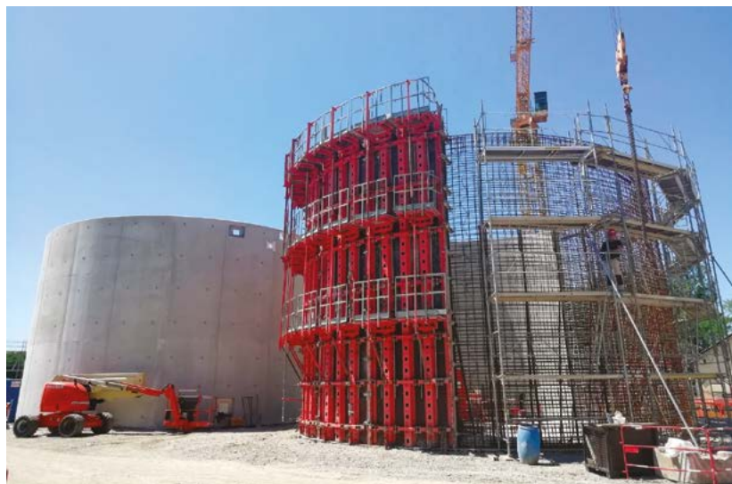
Chantier STEP à Benfeld (67)
